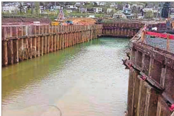
Momentan sieht die Baustelle noch aus wie ein Hafenbecken. Im Herbst 2023 soll hier die Umgehungsstraße verlaufen. Foto: F. Weyrich
